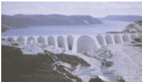
Le barrage Manic 5 au Québec.
